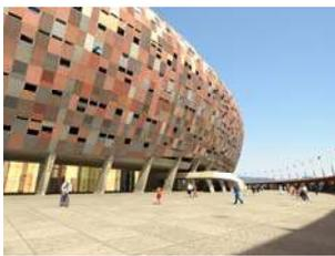
Das in der Geschichte der AFC vielleicht außergewöhnlichste Projekt hat (fast) nichts mit Aluminium zu tun, sondern nur mit der Erfahrung, wie man Elementfassaden konstruiert und montiert. Die Stadionhülle besteht aus verschiedenfarbigen glasfaserverstärkten 13mm starken Betonplatten, welche auf einen Stahlrahmen aufgenietet wurden. Der Rahmen wurde aus dünnen Stahlblechen gefertigt, welche mit Laser zugeschnitten, gekantet und verzinkt wurden. Alle Einzelteile
